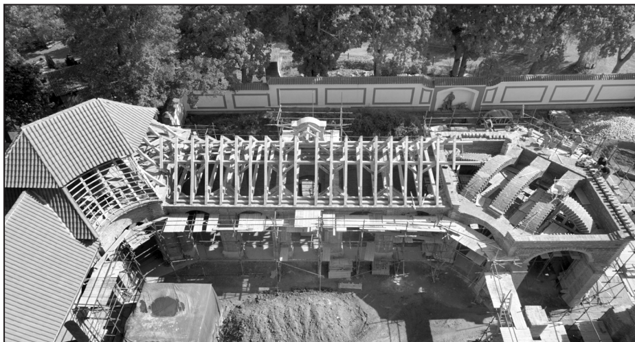
Pohled na dostavbu východního ambitu 16. září 2019.
