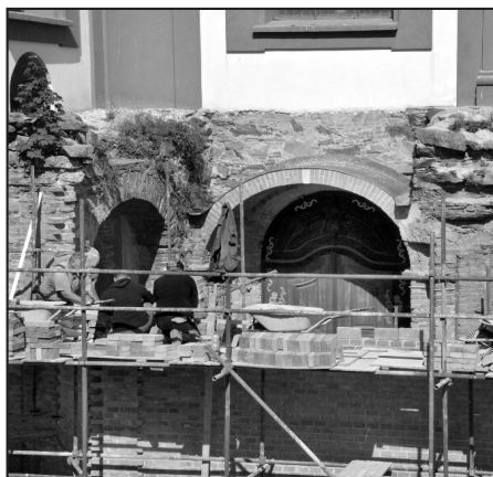
„Šmorce“ a dostavba kaple.
