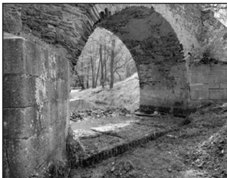
Rabštejn n./S., zpevnění podmostí.
