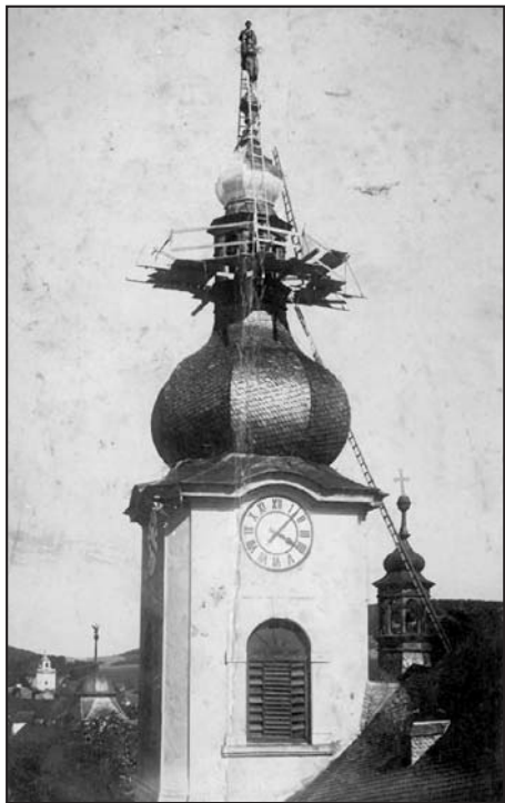
Oprava kostelní věže v Manětíně. Foto Z. Šubrt, 1986.
