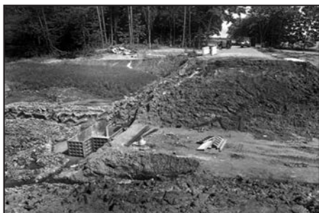
Budování nové výpustě.
