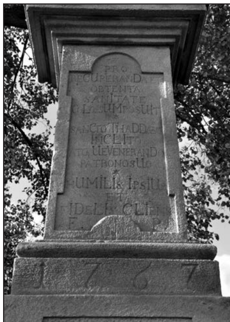
Detail čelní stěny podstavce se zvýrazněným nápisem a chronogramem (1767) po restaurování v roce 2022.
