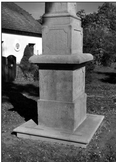
Detail spodní části sochy s doplněným kamenným stupněm po restaurování v roce 2022.
