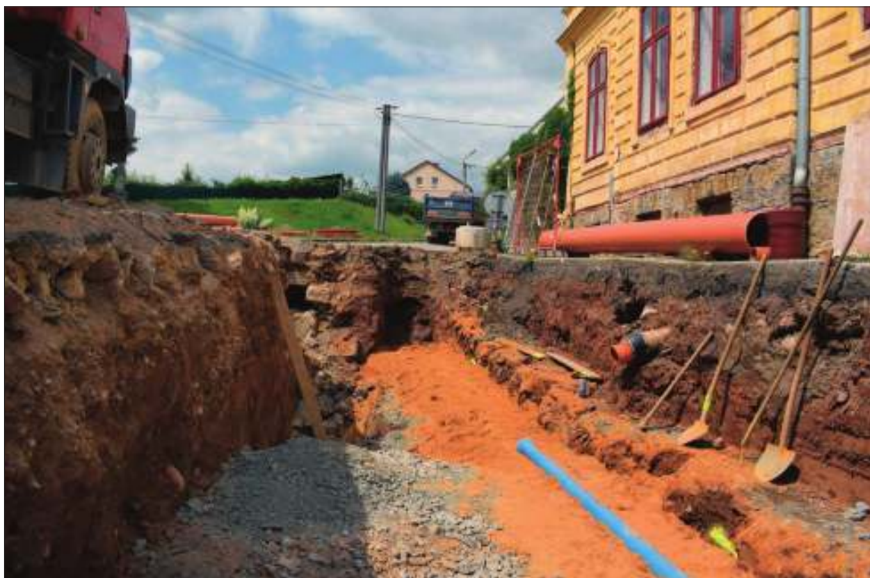
Archeologický dohled AR 11 2019 Manětín, kanalizace ČOV (29. 5. 2021).
