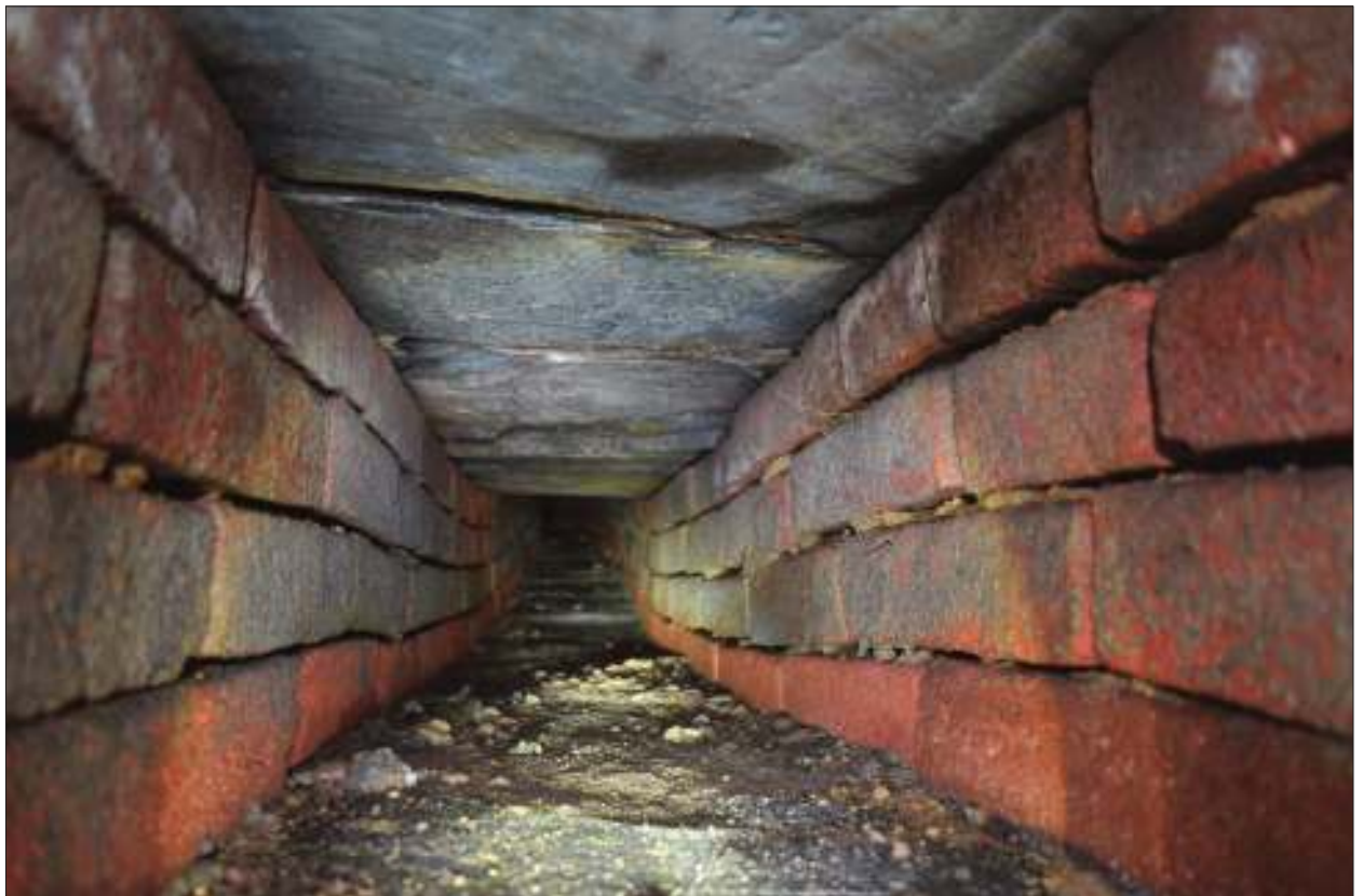
Archeologický dohled AR 11 2019 Manětín, kanalizace ČOV (29. 5. 2021).
