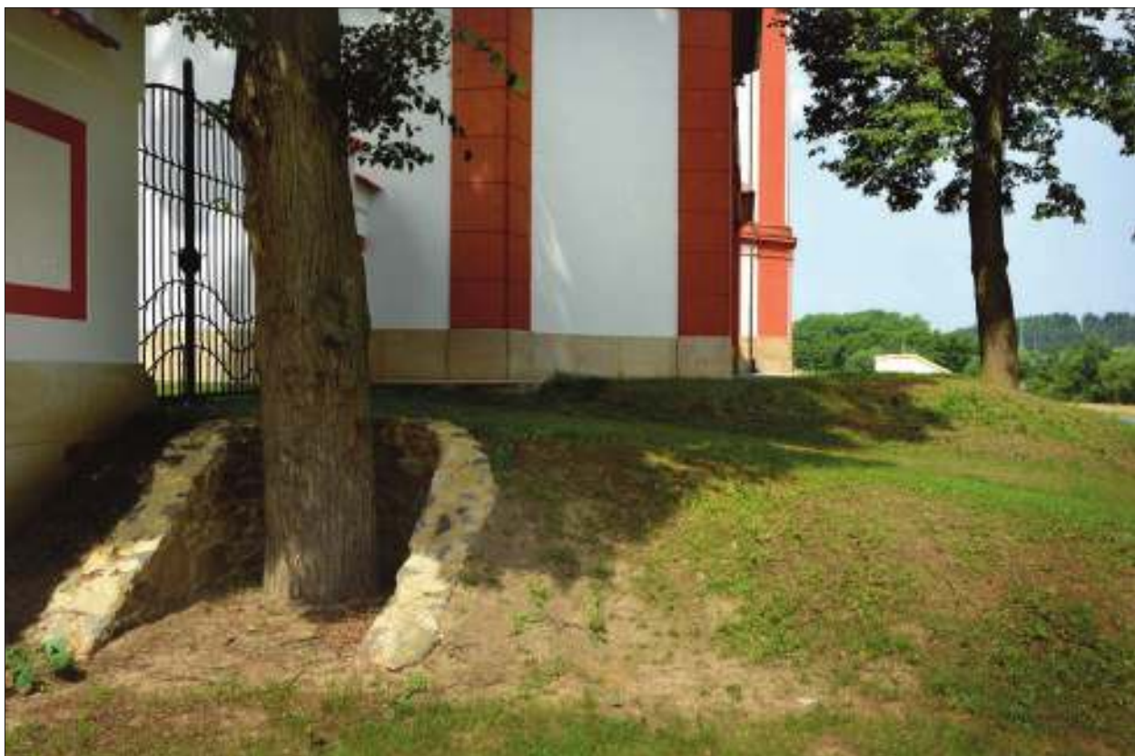
Ozdobnou mříží osazený vstup na nádvoří muzea a úprava terénu, 13. 7. 2021.
