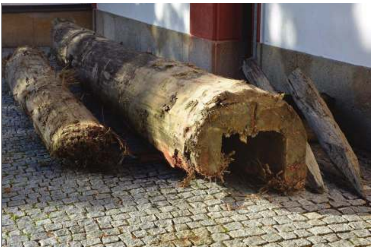
Archeologický dohled AR 6 Trojanský rybník – Oborák, 2021, vyjmuté dřevěné koryto z hráze rybníka Oborák (deponováno v Mariánské Týnici).
