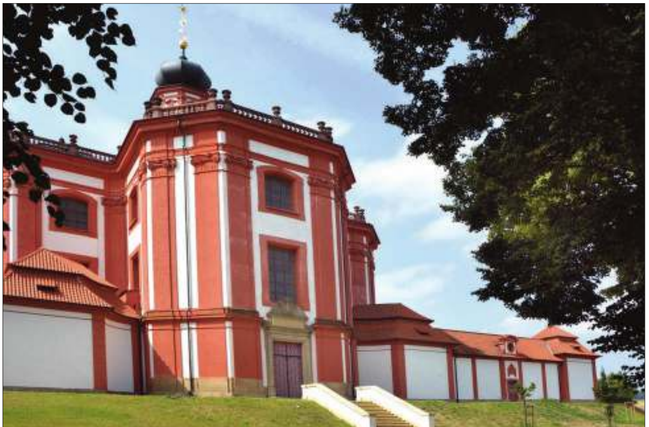
Stavba centrálního schodiště ke kostelu, 22. 4. (výše) a 13. 7. 2021 (níže).
