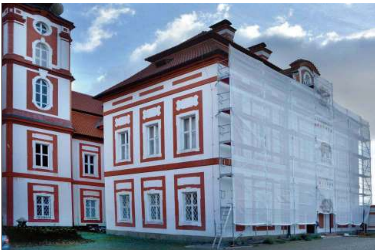
Oprava omítky a nátěru západního průčelí probostství, 9. 11. 2021.
