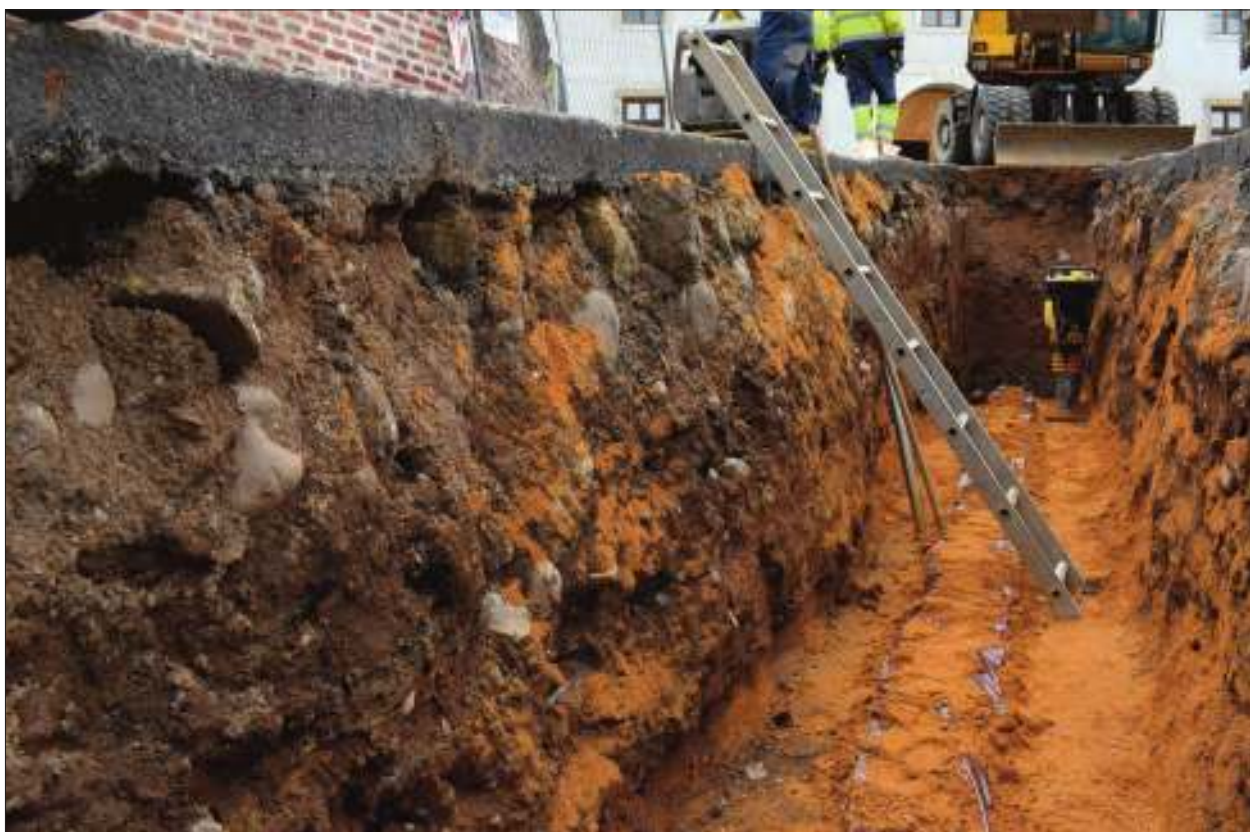
Archeologický dohled AR 11 2019 Manětín, kanalizace ČOV (28. 5. 2021).
