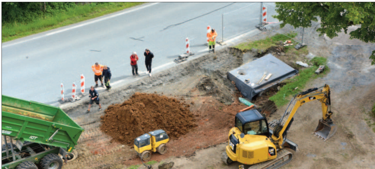
Stavební projekt s označením „II/2021 Mariánský Týnec, úprava napojení a odvodnění“, realizovaný se Správou a údržbou silnic Plzeňského kraje.
